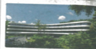
Das neue *****Hotel Lone lockt mit tollen Eröffnungsangeboten
