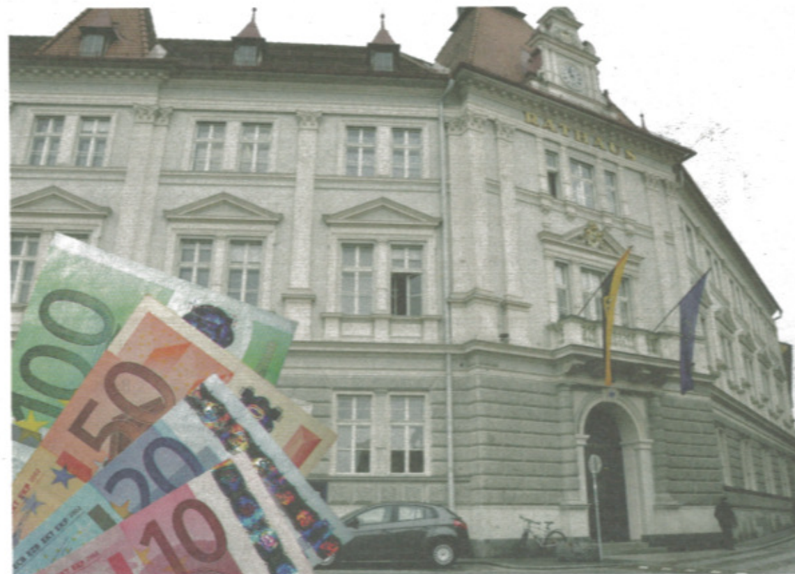
In Wolfsberg wird das Budget für 2012 unter anderem für die Sanierung der Volksschulen verwendet. FRIEDL, FOTOLIA
