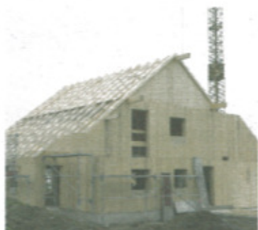
In nur drei bis vier Tagen wird ein Haus von den Wänden bis zur Decke gefertigt
