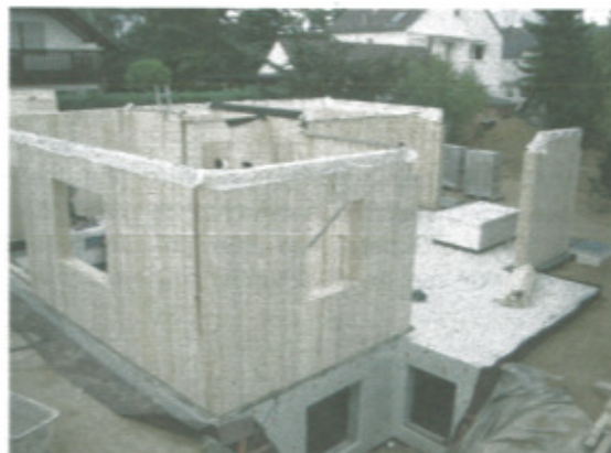
Die dazu notwendigen Holzelemente werden in Lavamünd gefertigt Foto: KK
