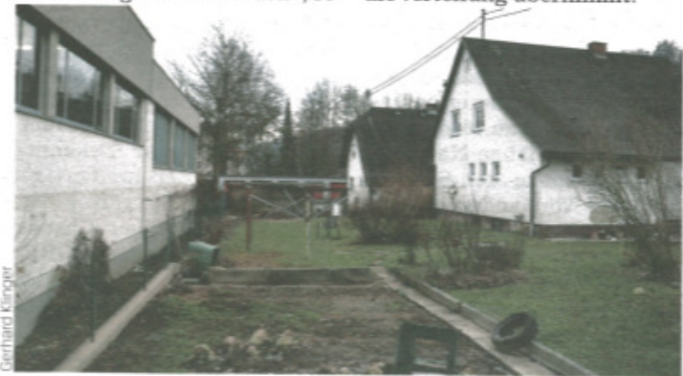
Diese beiden Häuser hinter dem Gemeindeamt in Lavamünd müssen wegen der Hochwasserschäden abgerissen werden.
