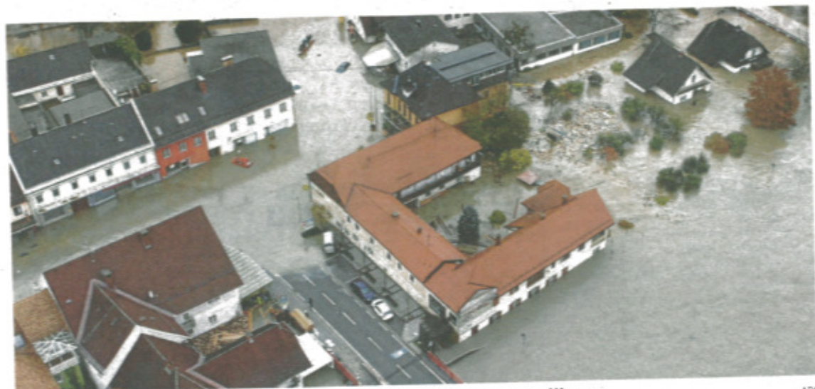
Rund zwei Meter tief stand der Ortskern von Lavamünd am 5. November unter Wasser
