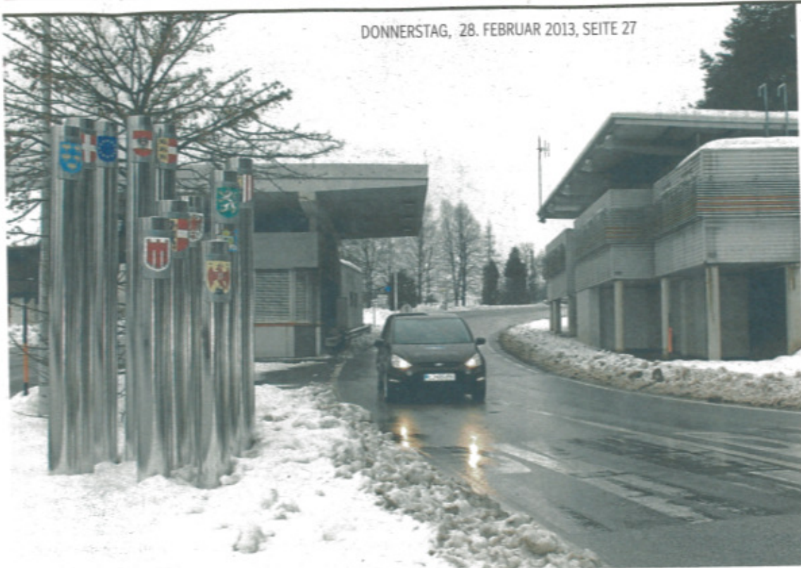
Geisterhaft: die leer stehenden Gebäude beim Grenzübergang in der Gemeinde Lavamünd
