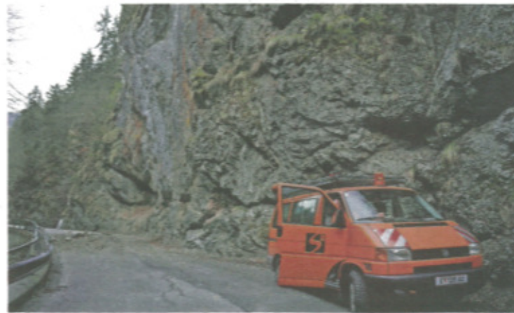
Aufräumarbeiten nach dem Felssturz: Die Bergrettung Ferlach musste loses Geröll über der Fahrbahn in der Klamm entfernen.
