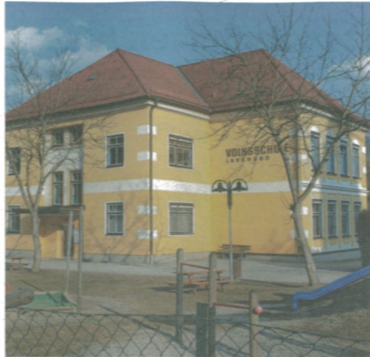
Ab Herbst wird neben anderen öffentlichen Gebäuden auch die Volksschule Lavamünd mit Fernwärme versorgt
