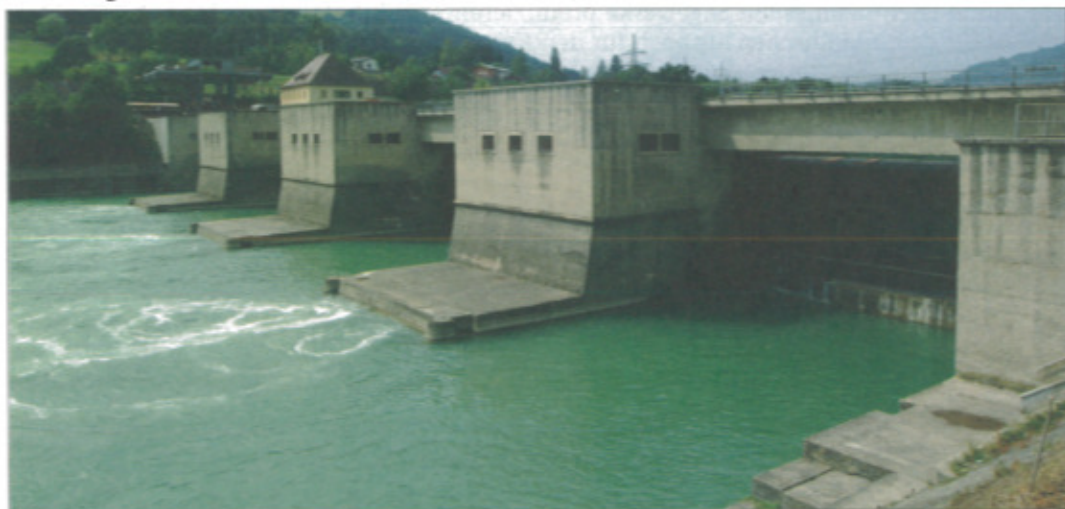
Das Drau-Laufkraftwerk in Lavamünd war ebenfalls in die Hochwasser-Vorsichtsmaßnahmen miteingebunden. Foto: Verbund
