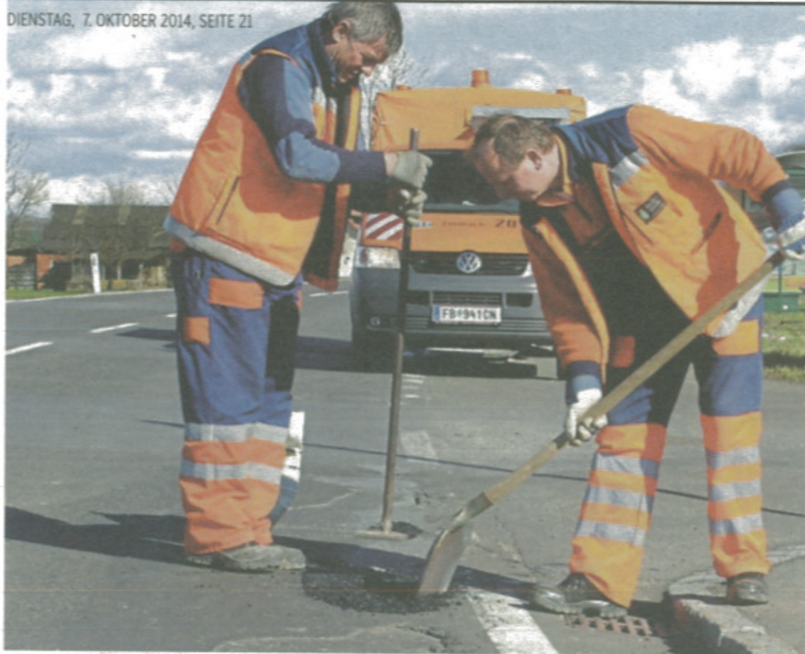
Die Straßen im Tal werden im Rahmen der Herbstoffensive der Landesstraßenbauabteilung saniert
