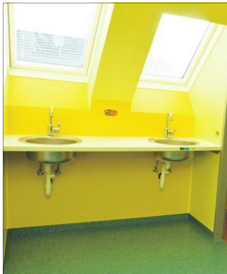
Kürzlich wurde in neue Sanitäräumlichkeiten investiert.
