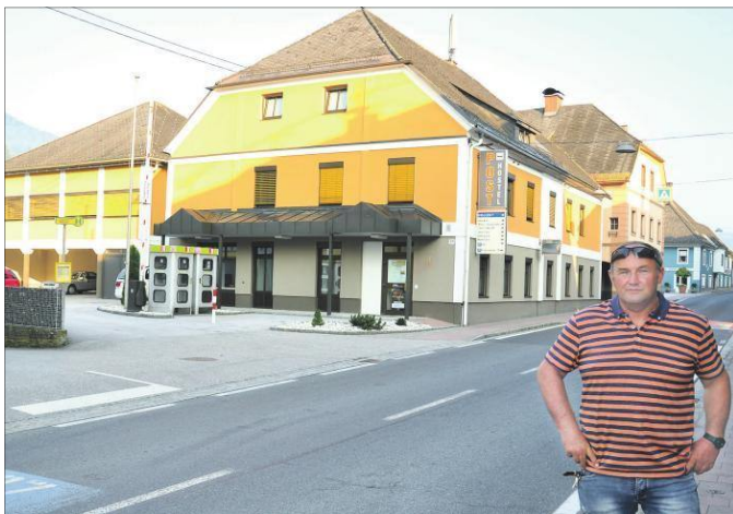
Bauunternehmer Herbert Retzl setzt als Besitzer auf eine kontinuierliche Entwicklung und vielfältige Nutzung des ehemaligen Lavamünder Postgebäudes.
