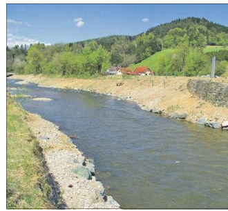
Die Sinuidalschwelle Altach wurde gänzlich entfernt. Flussauf der Schwelle wurde das Flussbett neu strukturiert und bietet nun einen vielfältigen Lebensraum. Mit der Entfernung der Schwelle wurde die erste Barriere flussauf der Lavant-Mündung in die Drau beseitigt. Ein Paradebeispiel für die umgesetzten Tätigkeiten. Fotos: Umweltbüro GmbH
