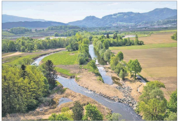
Laufverschwenkung Lavant Mettersdorf: Durch den Bau des neuen Flusslaufs wird die bestehende Lavant-Sohlstufe umgangen, die Fische können hier auf rund 400 Metern in einem neuen, strukturreichen und dynamischen Flussabschnitt barrierefrei wandern.
