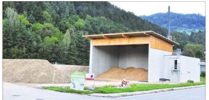
Das Heizwerk der HSH Nahwärme GmbH im Süden des Marktes wird künftig auch das Gemeindeamt Lavamünd mit Wärme beliefern. Foto: UN
