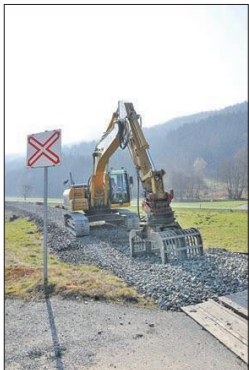
Auch in St. Paul sind die Bagger der Firma Meißner Gleisrückbau schon aufgefahren.
