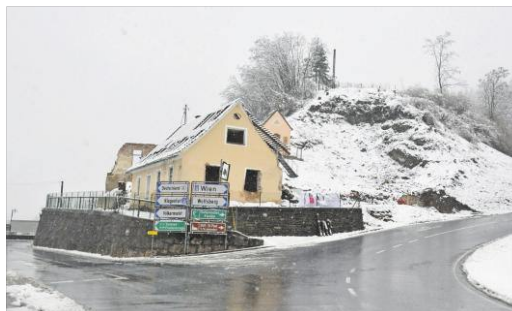
Die Watzingkreuzung soll umgebaut und damit sicherer werden. Dazu müssen auch zwei Gebäude abgerissen werden. Die Arbeiten wurden Anfang dieser Woche aufgenommen.
