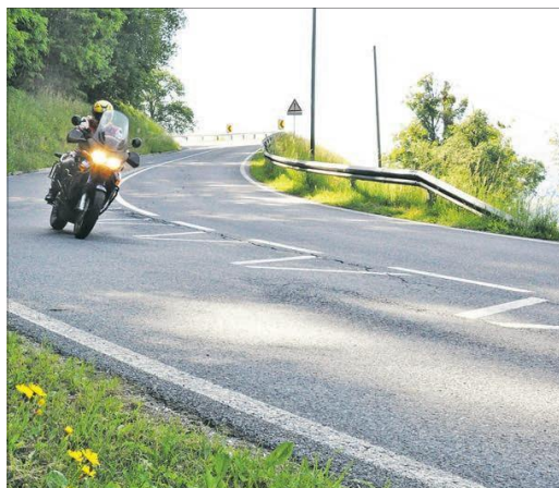
Mit der neuen Straßenmarkierung sollen die Motorradfahrer von der Fahrbahnmitte ferngehalten werden.
