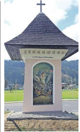
Die Arbeiten am »Roten Kreuz« sollen im November zu Ende gehen.
