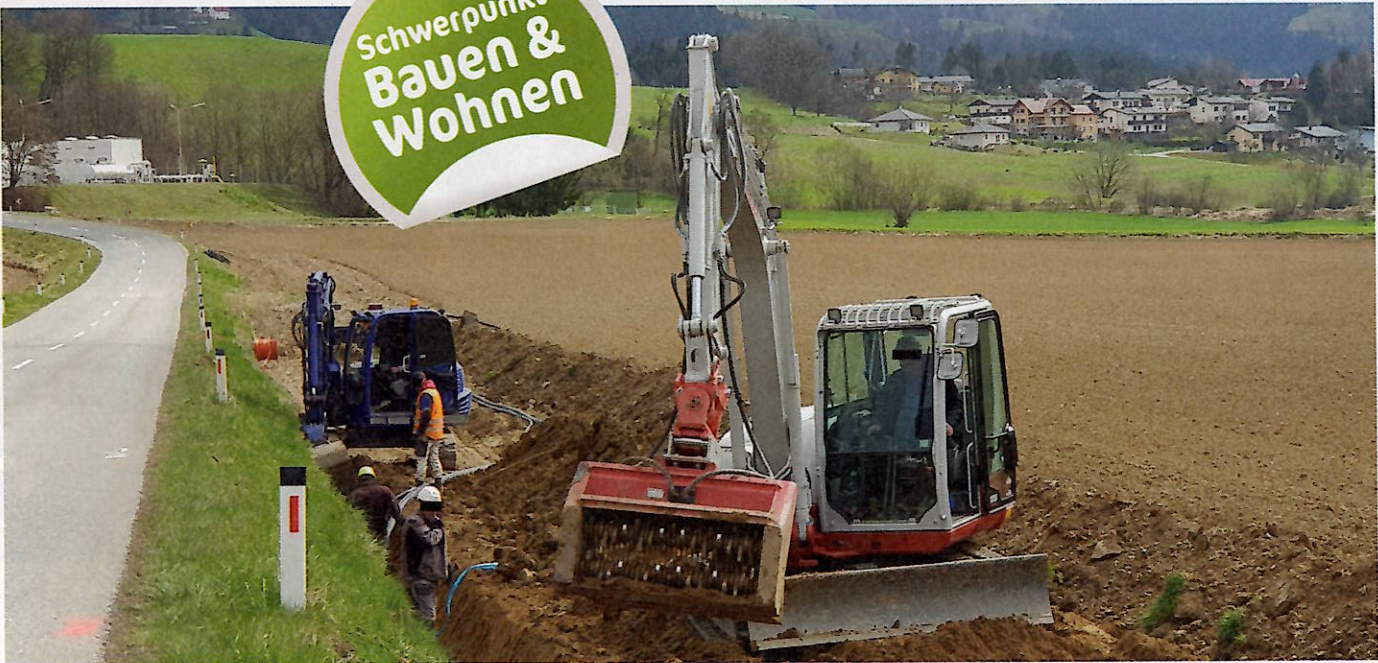
In Lavamünd wird beim Breitbandausbau ordentlich Gas gegeben, im Bild beim Verlegen von Lichtwellenleiterrohren
