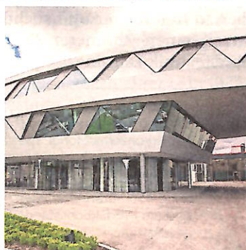
Geislinger GmbH, Bad St. Leonhard Bürogebäude
