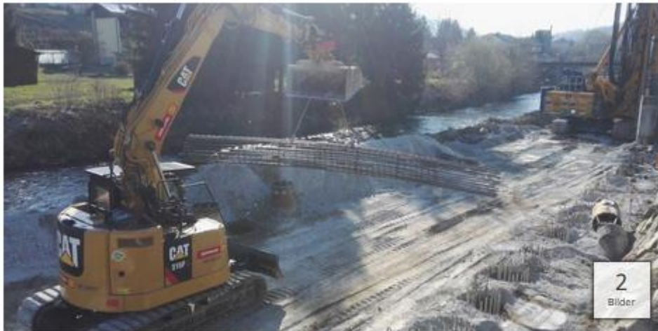
Am Hochwasserschutz Lavamünd wird derzeit weiter gebaut. Arbeiten befinden sich im geplanten Zeitrahmen. • Foto: Büro LR Fellner • hochgeladen von Simone Koller
