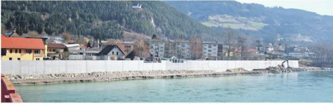
Das Bauarbeiten für das Projekt Hochwasserschutz Lavamünd laufen derzeit noch unabhängig von den Corona-Maßnahmen weiter. Die Fertigstellung des gesamten Projekts ist in drei bis vier Jahren geplant. Foto: Jäger
